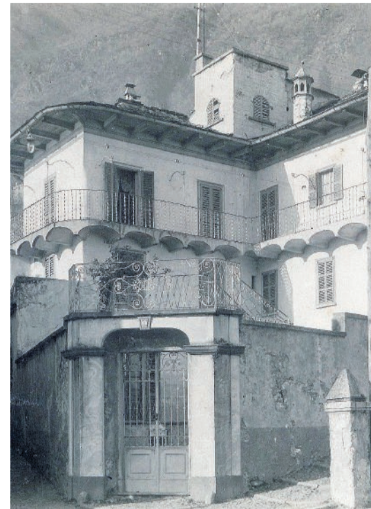
L'edificio in un'immagine d'epoca
